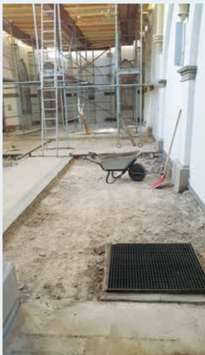
Vorarbeiten zur Erneuerung des Kirchenbodens.
