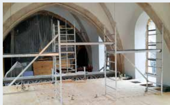
Arbeiten auf der Orgelempore.
