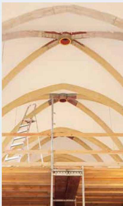
Sorgfältige Gestaltung des Rippengewölbes.
